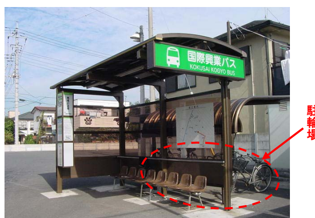
図 バス停の整備例（埼玉県やすらぎバスステーション整備）
