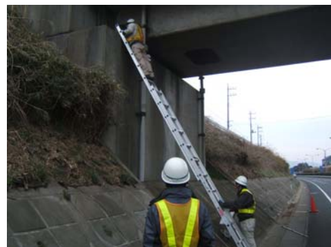
橋梁点検状況1
