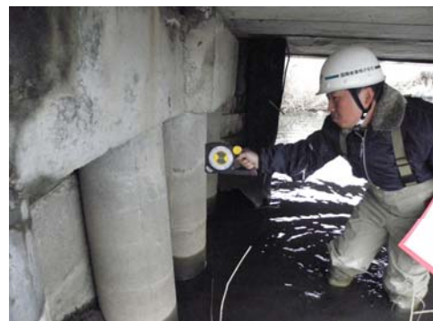
橋梁点検状況2
