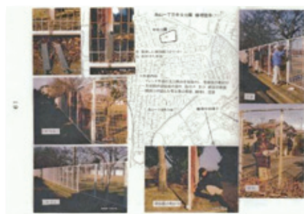
「なおそう会」公園フェンスを補修
