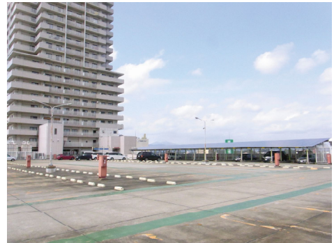
■十分な駐車台数を有している既存建物
