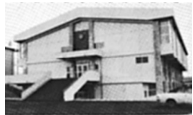
昭和54年11月24日 待望の体育館竣工
