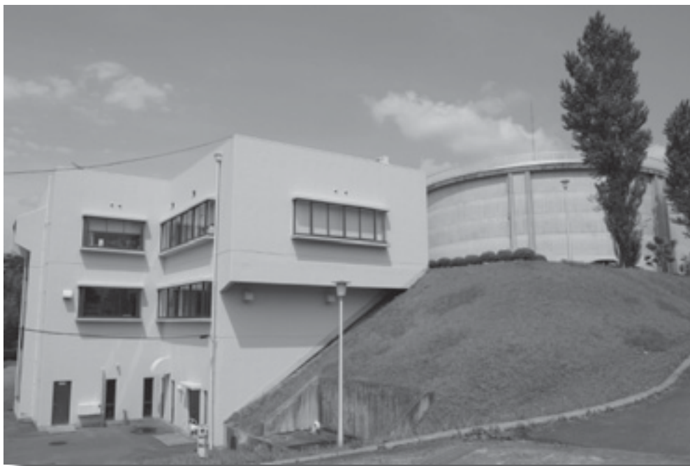
大岩田配水場
