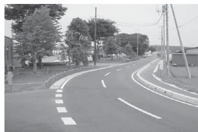
道路新設改良事業(市道佐野子15号線)
