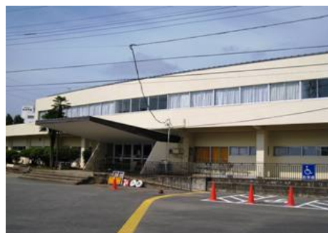
陸上競技場管理棟
