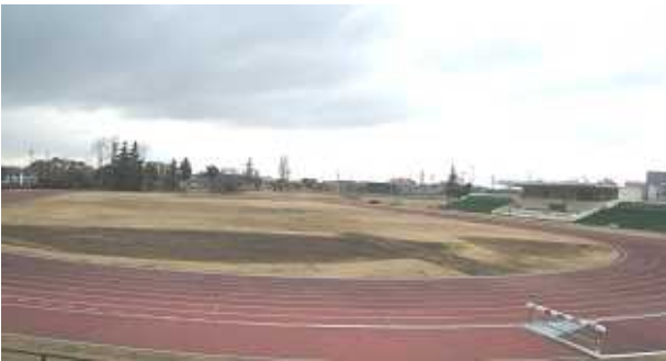
川口運動公園陸上競技場
