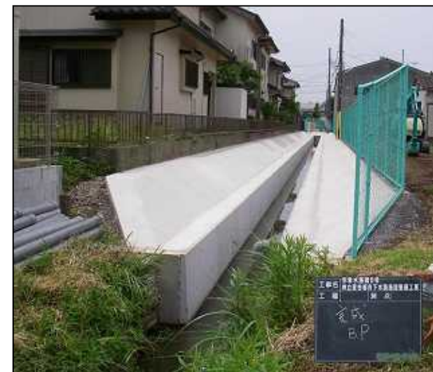
平成21年度整備状況 神立菅谷都市下水路（神立中央五丁目地内）
