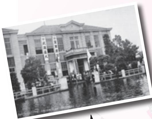
洪水時の土浦町役場 (昭和13年)
