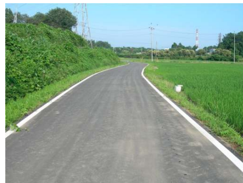
農道整備箇所
