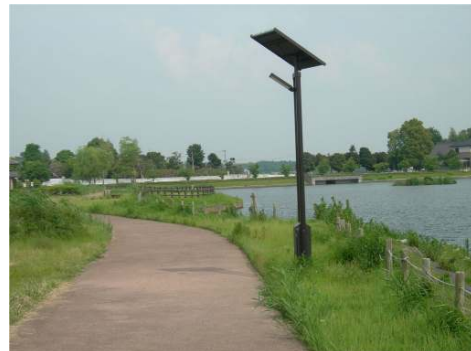
外灯設置箇所
