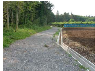
排水整備箇所
