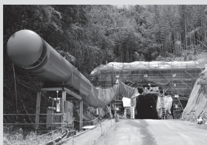
朝日トンネル
