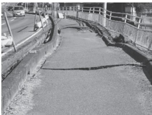
液状化した歩道。左の車道の高さと比較すると、どれだけ陥没したのかが分かる。(新治地区)
