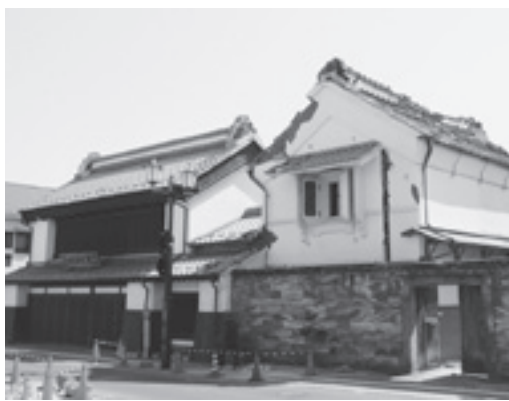
強い揺れを受け、多くの家屋で瓦が落下したり、屋根の一部が損壊するなどした。(まちかど蔵)
