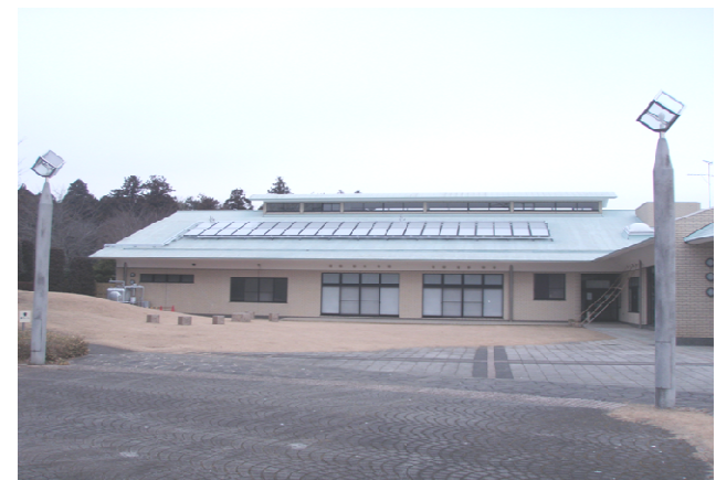
平成23年度 太陽熱温水器設置事業 設置場所：新治総合福祉センター
