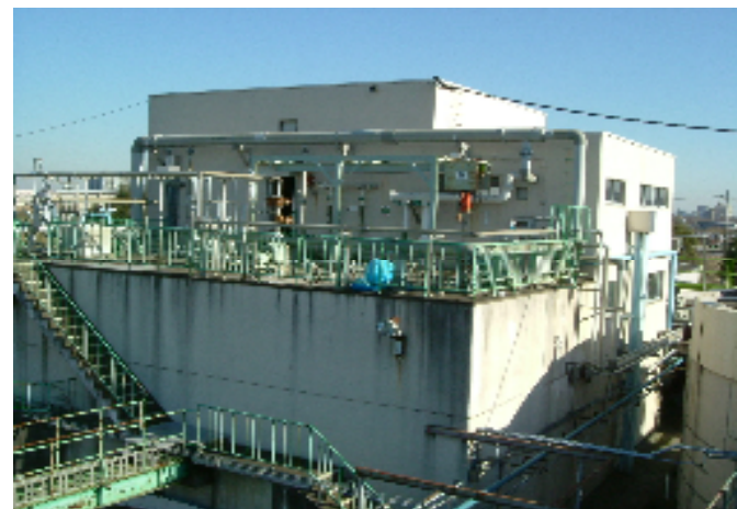
衛生センター 水処理・脱水機設備棟
