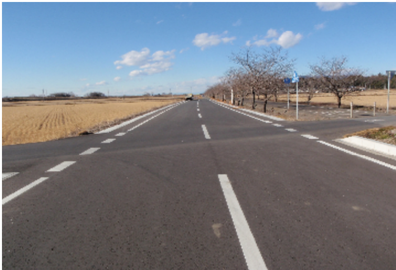
市道虫掛66号線整備状況
