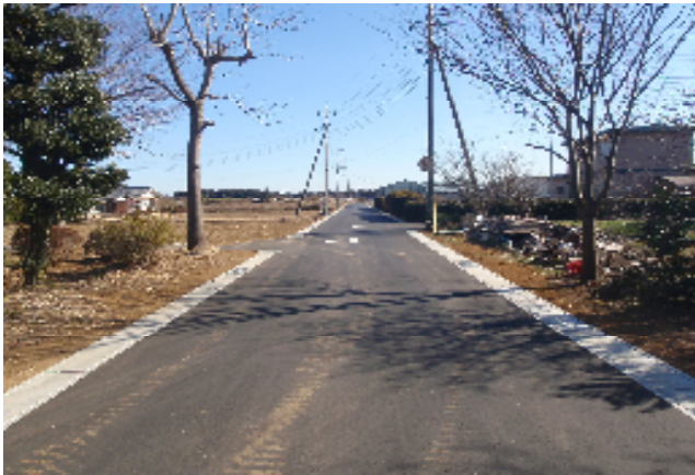
市道小山崎90号線整備状況
