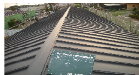
竹の入住宅屋根改修工事（完成）
