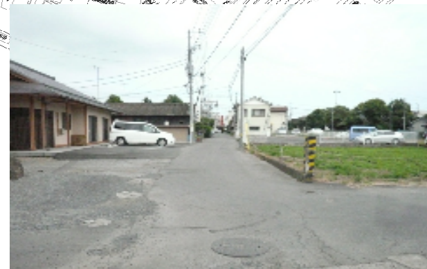
現況（公民館前から神立駅方面を望む）
