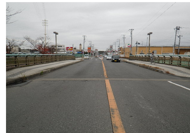
新川9号橋（神天橋）現況
