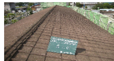
竹の入住宅屋根改修工事（着工前）
