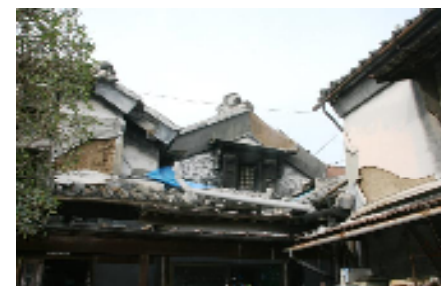
県指定建造物「矢口家住宅」
