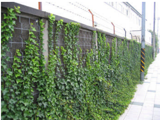
▲壁面緑化により、長大な万年塀の閉鎖感を軽減した例
