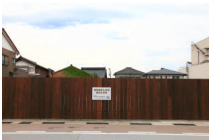
▲周辺の景観に配慮した色彩、素材を使用した仮囲いの例
