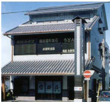
▲3階の壁面を後退させた店舗の例
