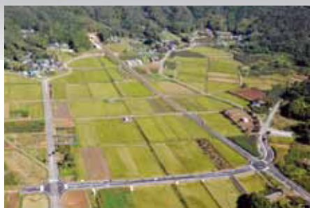
▲空からみた朝日トンネル
