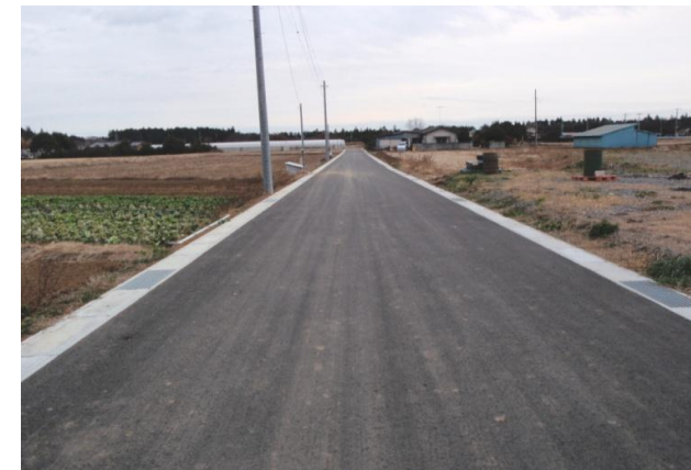
市道小山崎90号線整備状況
