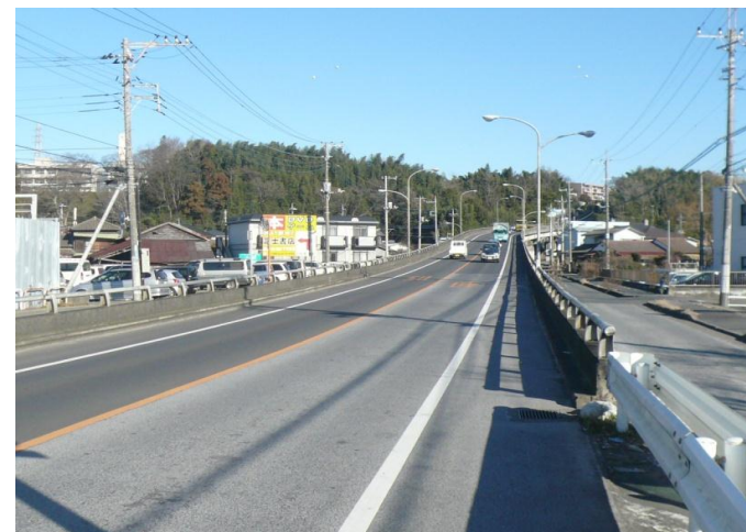
東真鍋1号橋（木田余立体橋）現況
