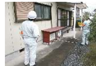
耐震診断の様子
