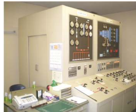
監視制御設備
