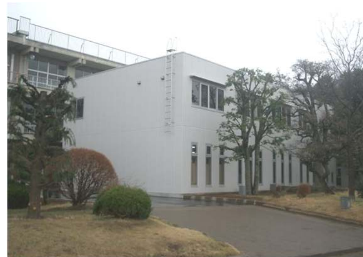
(参考) 第五中学校特別教室棟増築工事 平成23年度竣工
