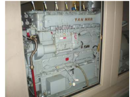
自家発電設備
