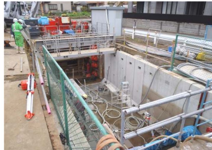
神立菅谷雨水幹線整備状況
