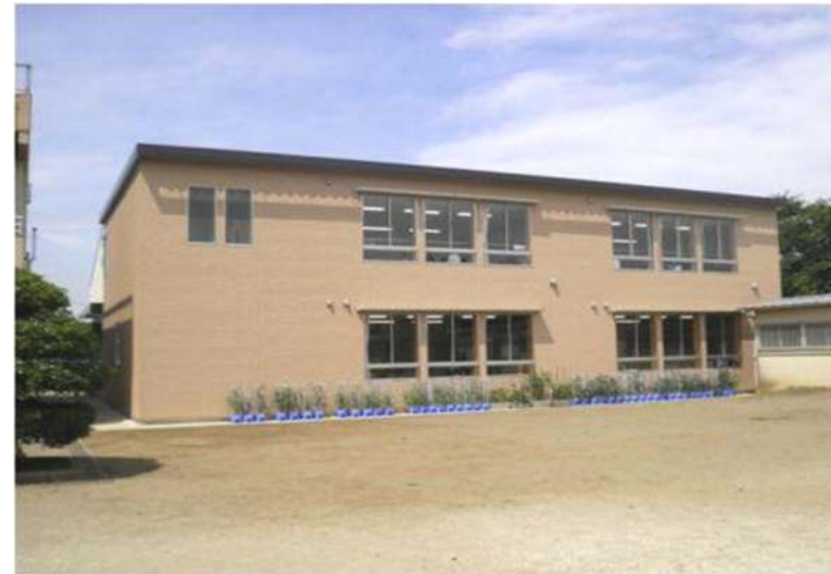
平成22年度竣工上大津東小学校増築校舎
