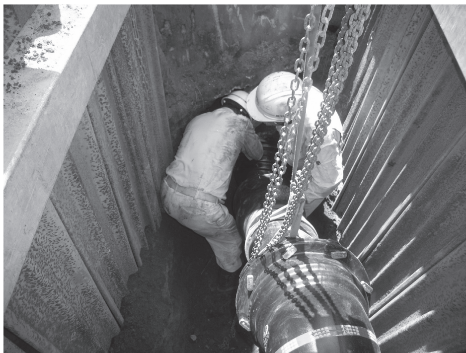
配水管布設工事
