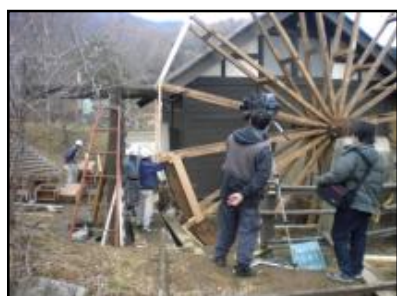
水車修復作業とその撮影
