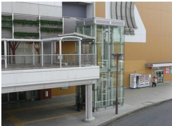
土浦駅西口広場エレベーター
