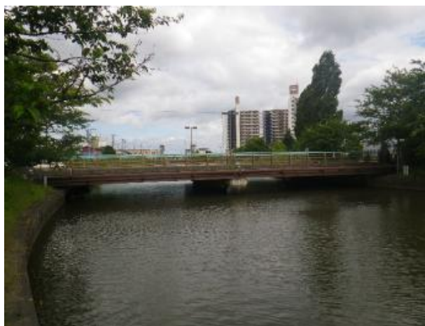
新川9号橋(神天橋)
