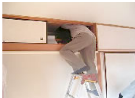
耐震診断の様子
