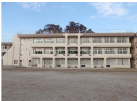
東小学校耐震補強及び大規模改造工事
