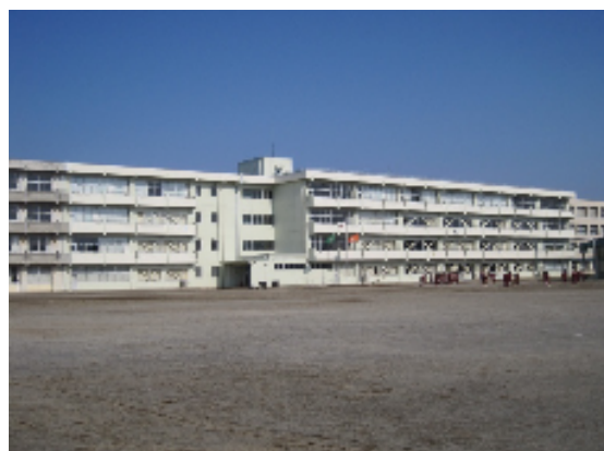
土浦第三中学校耐震補強及び大規模改造工事
