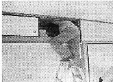
←耐震診断の様子
