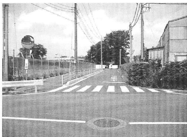
市道神立102号線（歩道の増設）
