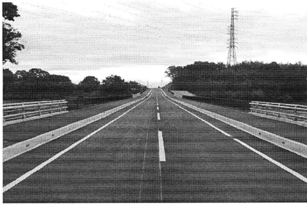
平成24年度供用開始区間
