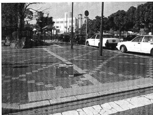
荒川沖駅西口点字ブロックの補修
