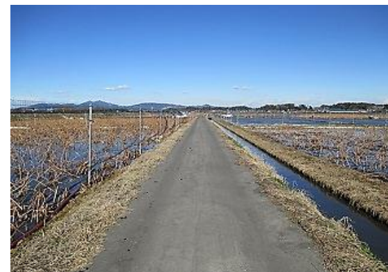
農道舗装（完成）
