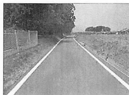
整備箇所（坂田地区）
