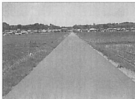
農道舗装箇所
