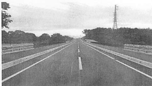
平成24年度供用開始区間
