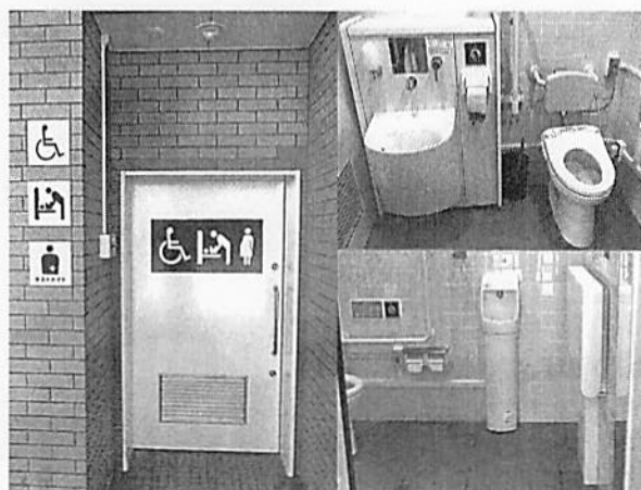
荒川沖駅西口公衆トイレバリアフリー化工事
