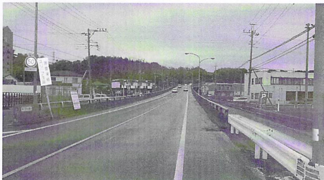
東真鍋1号橋（通称：木田余立体橋）
