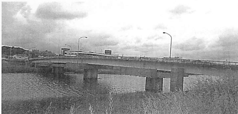
桜川1号橋（通称：銭亀橋）
