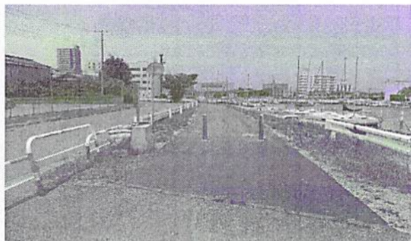
港町遊歩道整備工事
