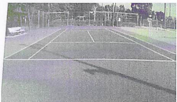
霞ヶ浦総合公園テニスコート災害復旧工事
