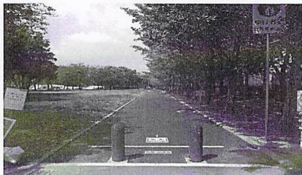
乙戸沼公園ジョギングコース整備工事
