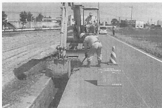
老朽管更新工事
