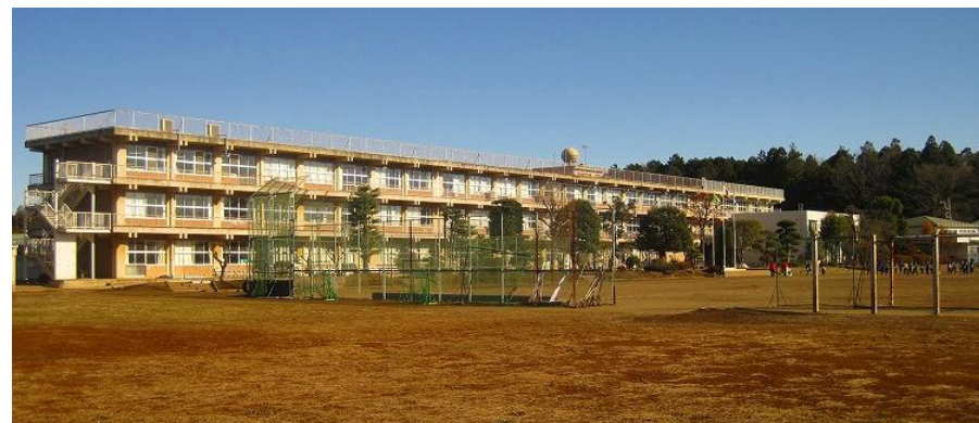
土浦第五中学校校舎棟
