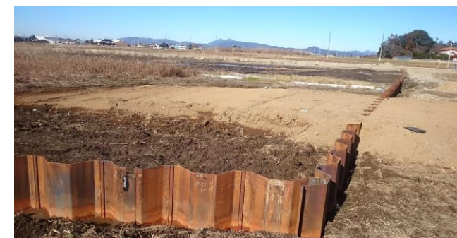
神立菅谷雨水幹線調整池工事整備状況
