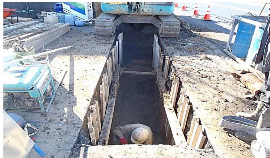
荒川沖第二処理分区荒川沖地内整備状況
