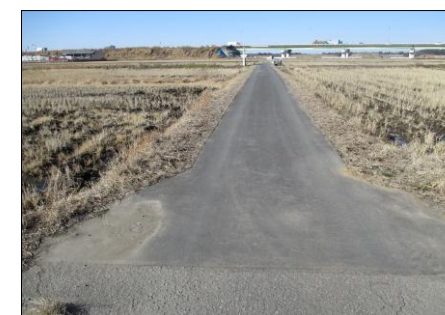
農道舗装工（完成例）
