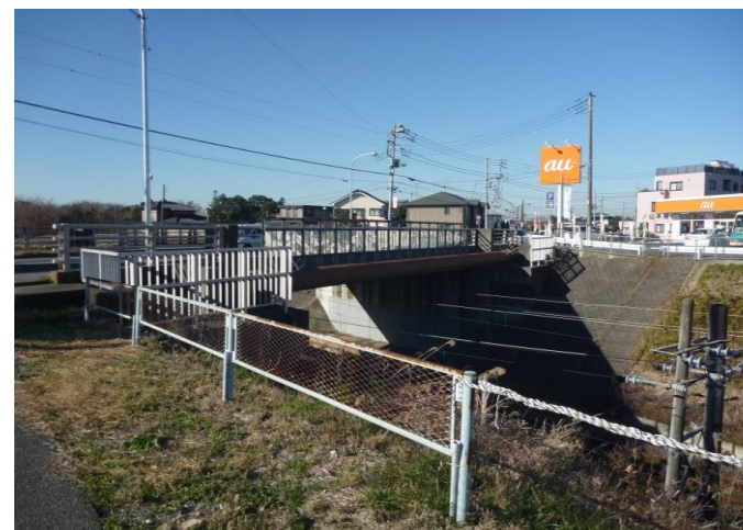
常磐線2号橋（三番橋）現況
