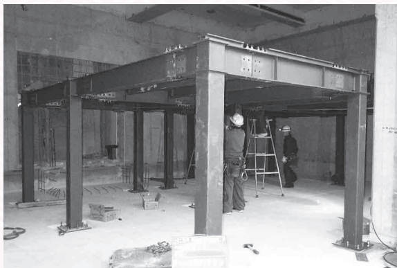
▲写真① 鉄骨工事の様子
