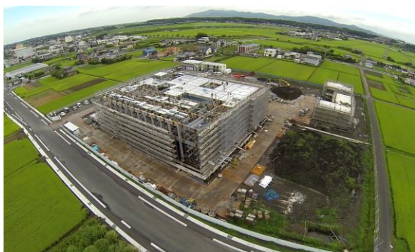
建設中の新消防庁舎
