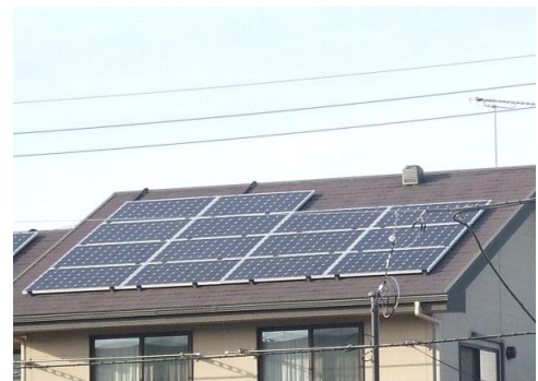
太陽光発電システム
