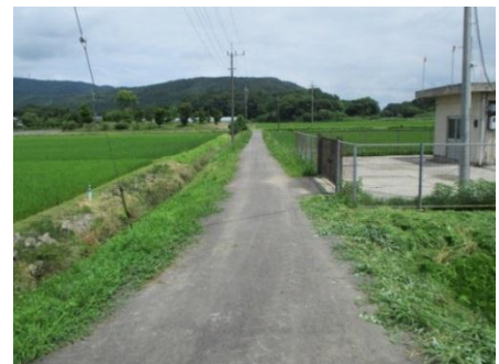
農道舗装箇所
