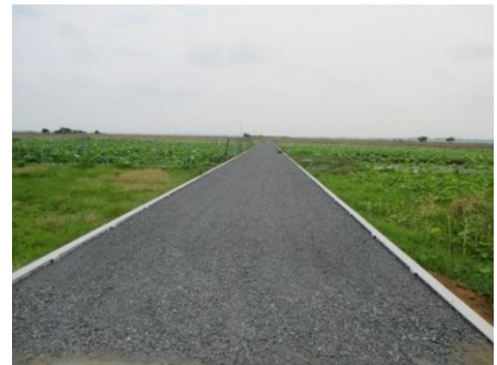
農道改良箇所
