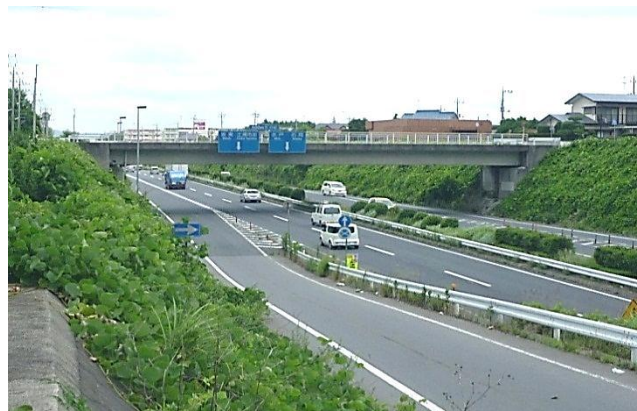
国道6号3号橋（通称：中高津跨道橋）
