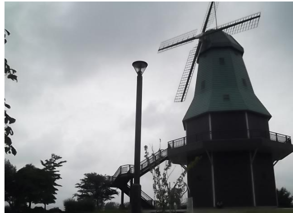
霞ヶ浦総合公園園路灯LED化工事
