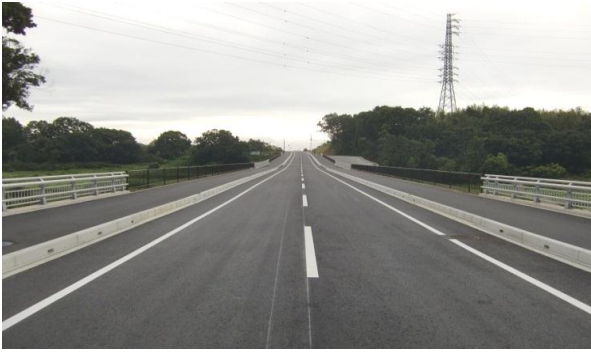
平成24年度供用開始区間
