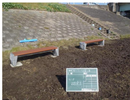
設置したベンチ（桜川左岸、銭亀橋付近）
