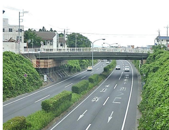
国道6号2号橋（通称：永国跨道橋）
