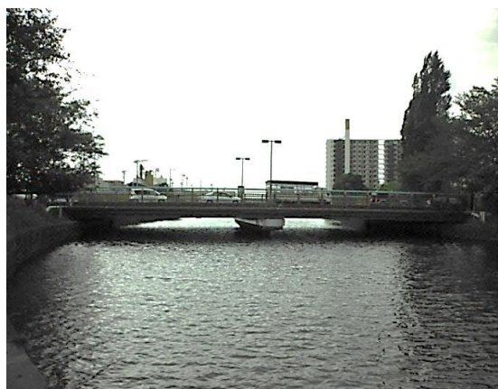
新川9号橋（通称：神天橋）
