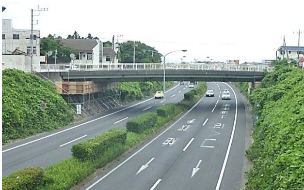
国道6号2号橋（通称：永国跨道橋）
