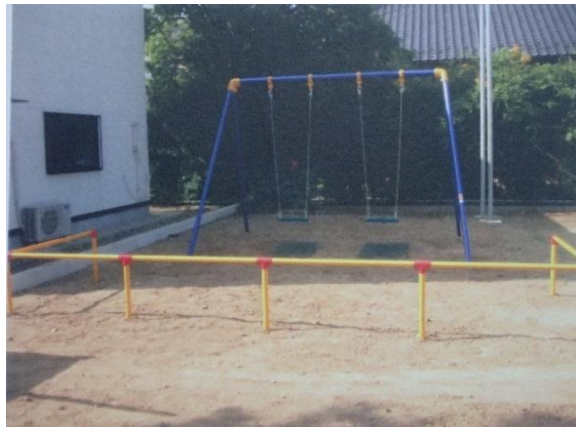
遊具更新工事
