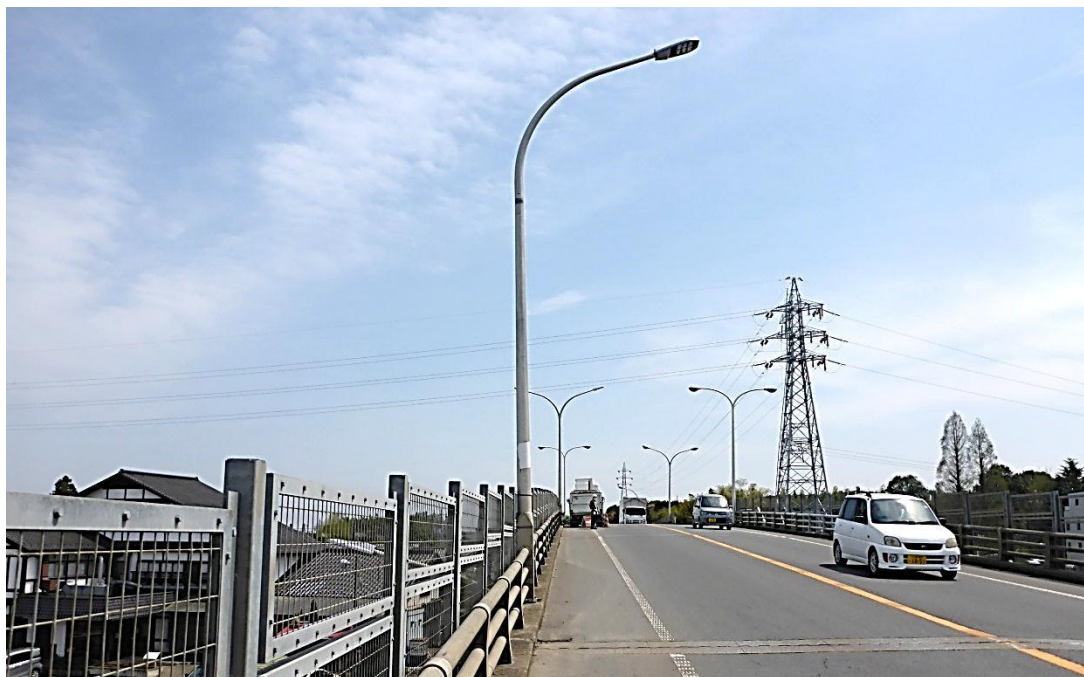
市道Ⅰ級3号線（神立跨線橋上）
