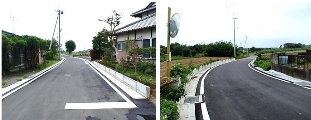
市道新治中30号線改良工事
