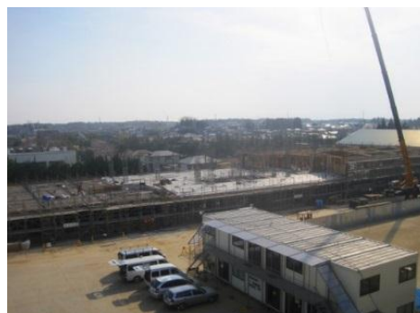
都和小学校 工事現況
