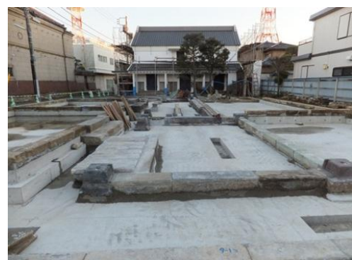
店蔵・袖蔵 基礎工事
