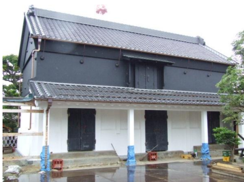
元蔵 完成状況
