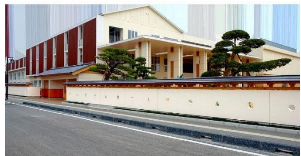
土浦小学校 正門付近
