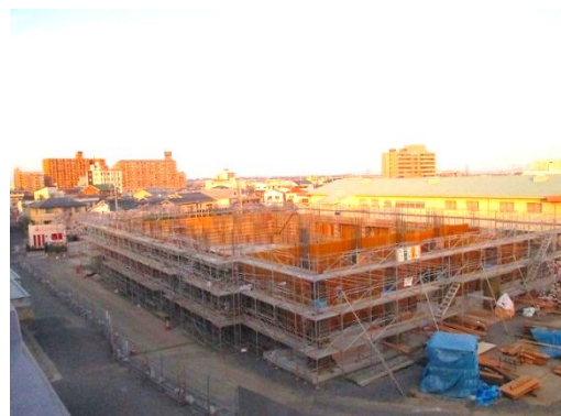
第二小学校 屋内運動場 工事現況
