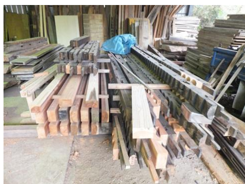
解体部材の加工修理
