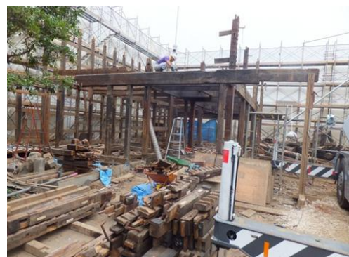
店蔵・袖蔵 解体工事
