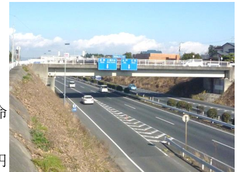
国道6号5号橋 (中高津第二跨道橋) 現況
