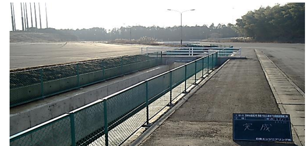
西根竹の入都市下水路整備状況
