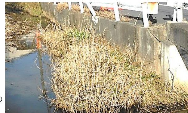
新川擁壁現況
