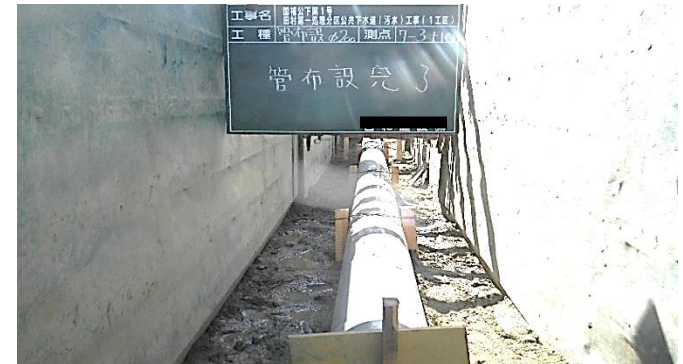
田村第一処理分区手野町地内整備状況
