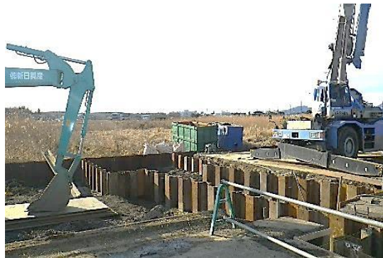
神立菅谷雨水幹線調整池整備状況
