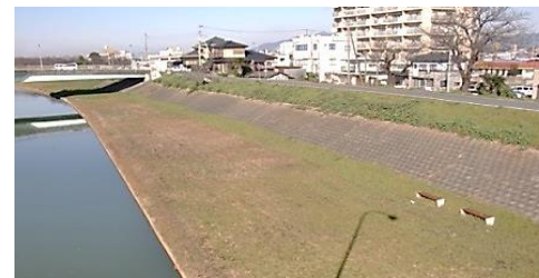
桜川左岸（土浦橋・銭亀橋間）現況
