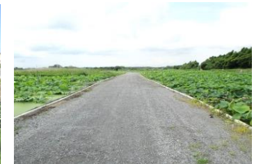
農道改良工（完成）
