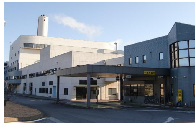
清掃センター外観
