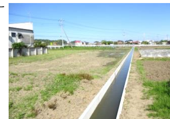
排水路整備工（完成）
