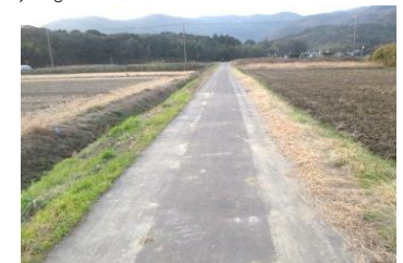
農道舗装工（完成）
