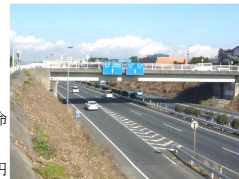
国道6号5号橋 (中高津第二跨道橋)現況
