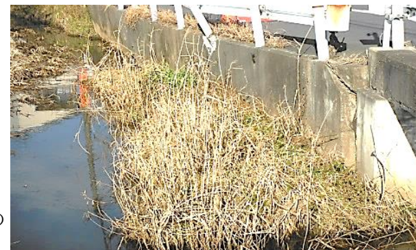
新川擁壁現況
