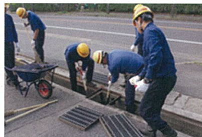
工場前雨水側溝清掃
