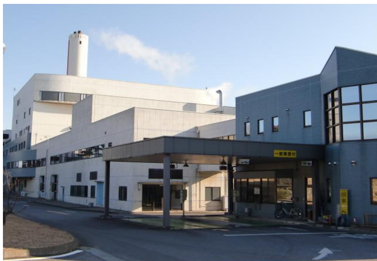
清掃センター外観
