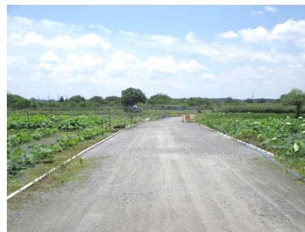
農道改良箇所
