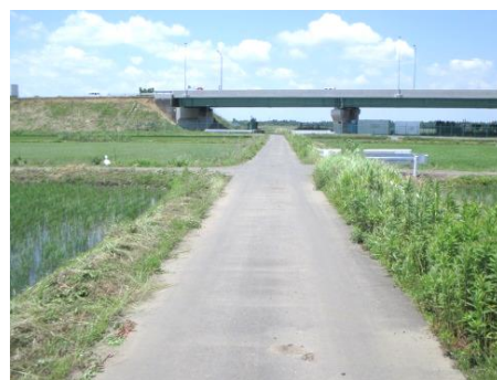
農道舗装箇所
