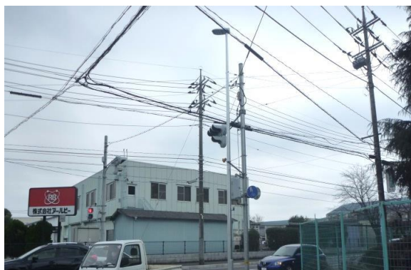
道路照明施設修繕工事（市道Ⅰ級3号線）
