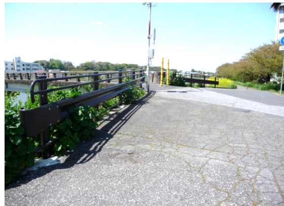
修繕したガードレール（桜川左岸，匂橋付近）
