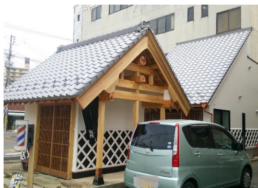
景観形成事業（中城通り地区） 床屋SORA店舗修景工事
