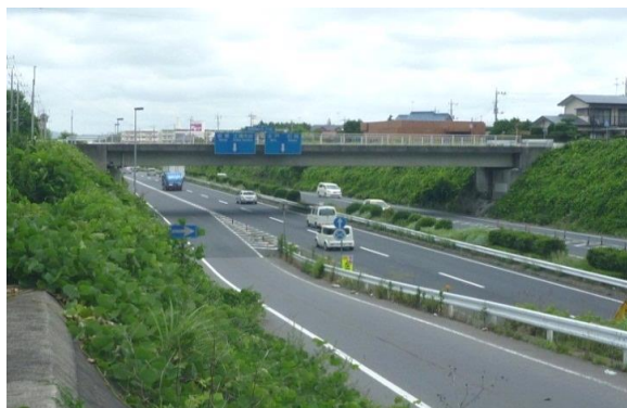
国道六号3号橋（通称：中高津跨道橋）
