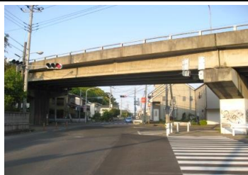
東真鍋1号橋（通称：木田余立体橋）
