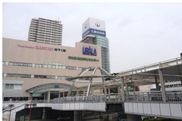
完成した既設ペデシェルター
