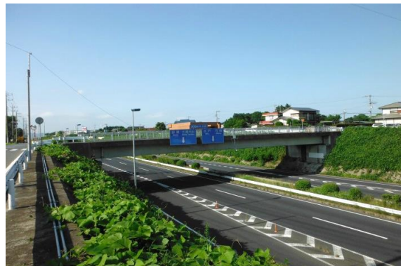
国道六号5号橋（通称：中高津第2跨道橋）
