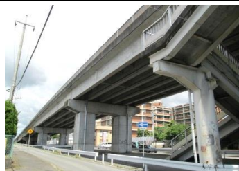
常磐線5号橋（通称：真鍋跨線橋）
