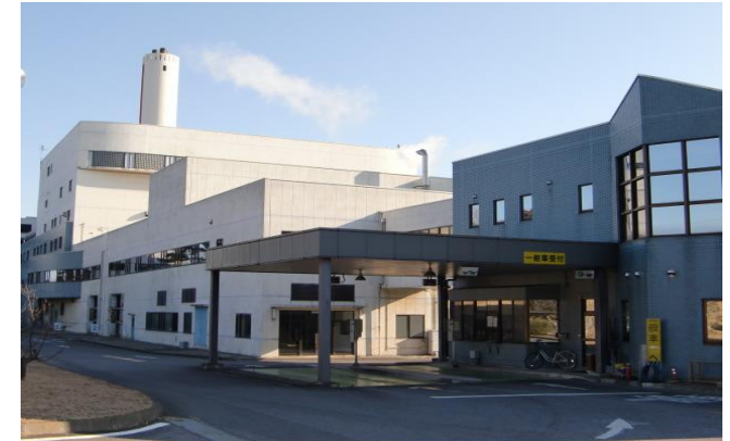
清掃センター外観
