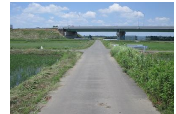
農道舗装工（完成）
