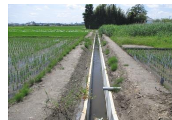
排水路整備工（完成）
