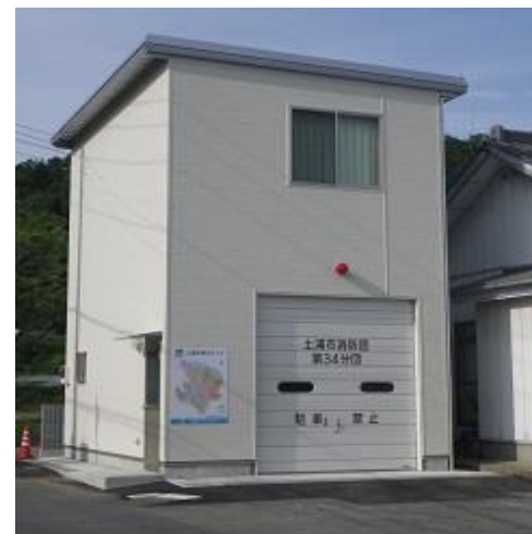
平成26年度建築 消防団車庫（第34分団 下坂田）
