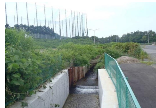
西根竹の入都市下水路整備状況
