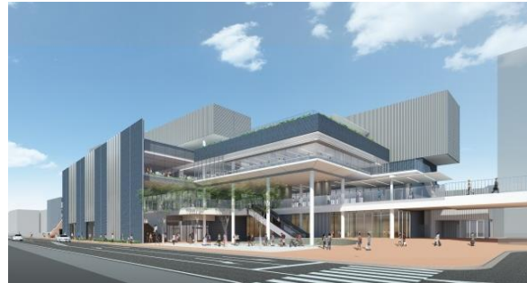
土浦駅前北地区再開発ビル
