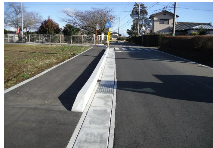
市道Ⅱ級9号線（田村町）整備状況
