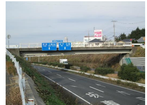
国道6号6号橋 (中高津地内) 現況
