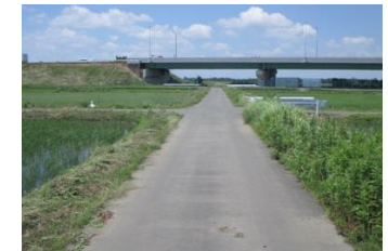
農道舗装工（完成）
