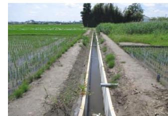
排水路整備工（完成）
