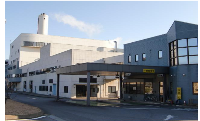
清掃センター外観
