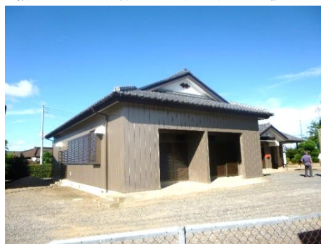
名 称：中都町農村集落センター 所 在 地：中都町三丁目3201番1 修繕内容：耐震補強、トイレ（水洗化）他
